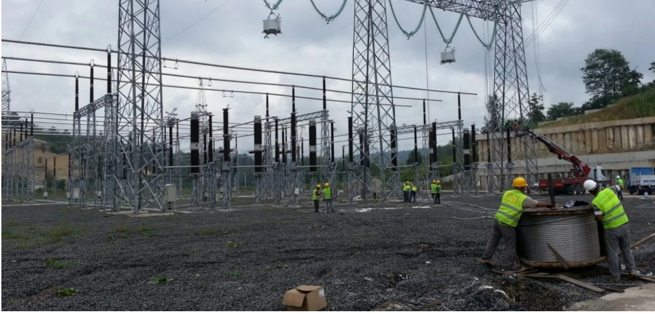
Şalt sahası çalışmaları / Switchyard works · Şirket arşivi / Company archive
